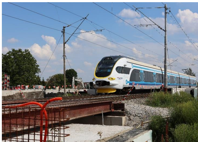
Slika 5. Željeznička postaja Sesvetska Sela – u izgradnji
